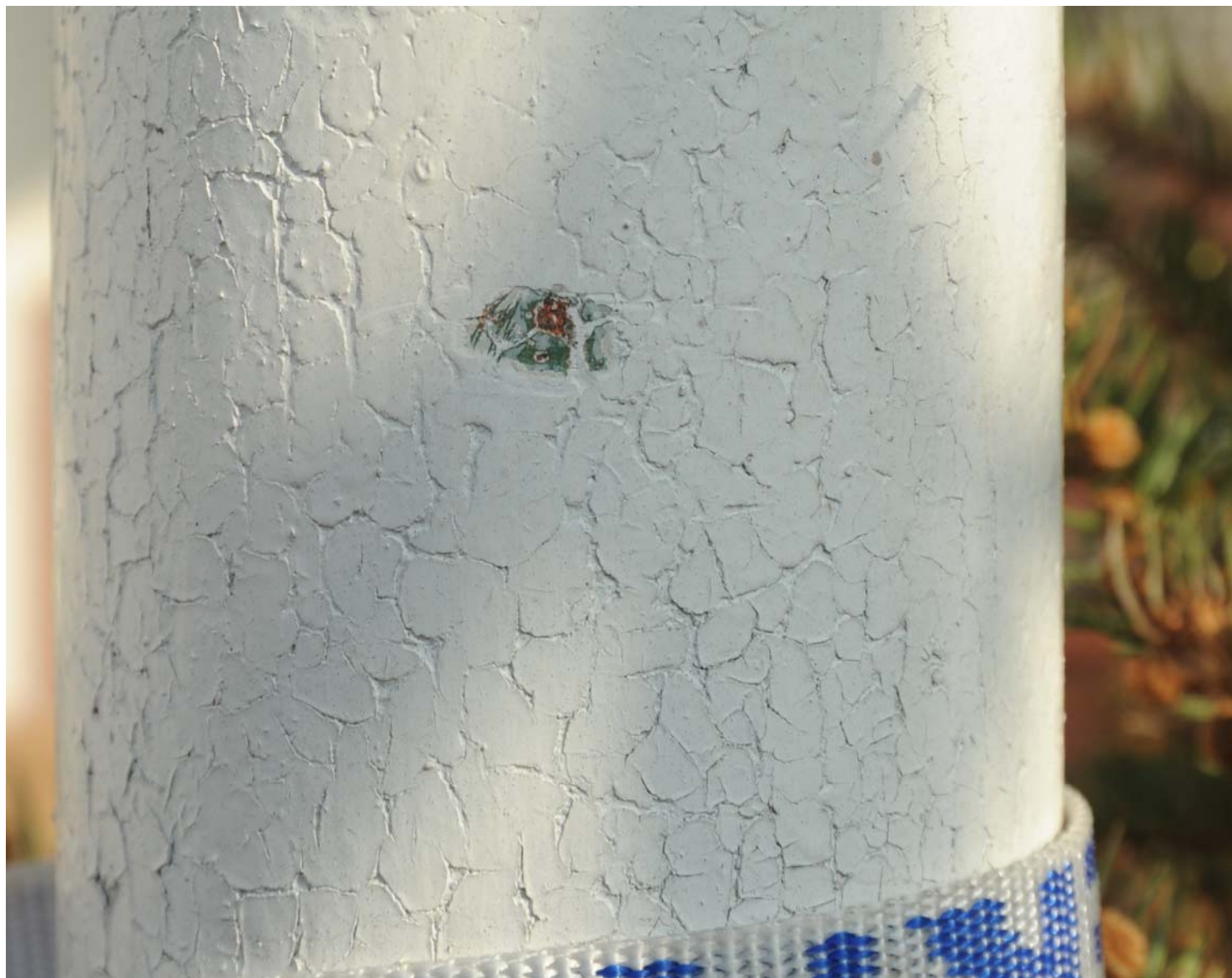
56. Budapest, II. kerület, Napraforgó utca 18. Teraszoszlop feltárt festési rétegei Barka Gábor felvétele 2015. február 12. (DSC_3240)
