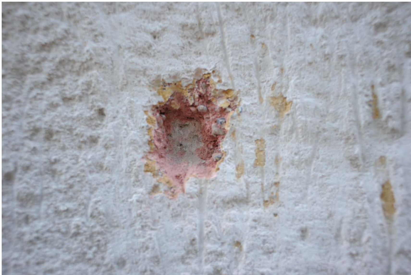
54. Budapest, II. kerület, Napraforgó utca 18. Utcai homlokzat feltárt festési és vakolat rétegek Barka Gábor felvétele 2015. február 12. (DSC_3261)
