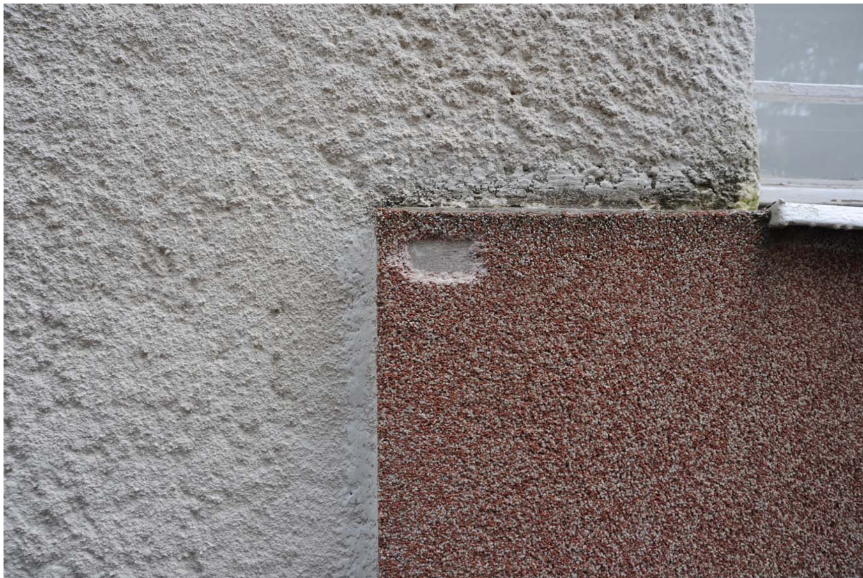
53. Budapest, II. kerület, Napraforgó utca 18. A műkőlabazat feltárási ablak Barka Gábor felvétele 2015. február 12. (DSC_3269)
